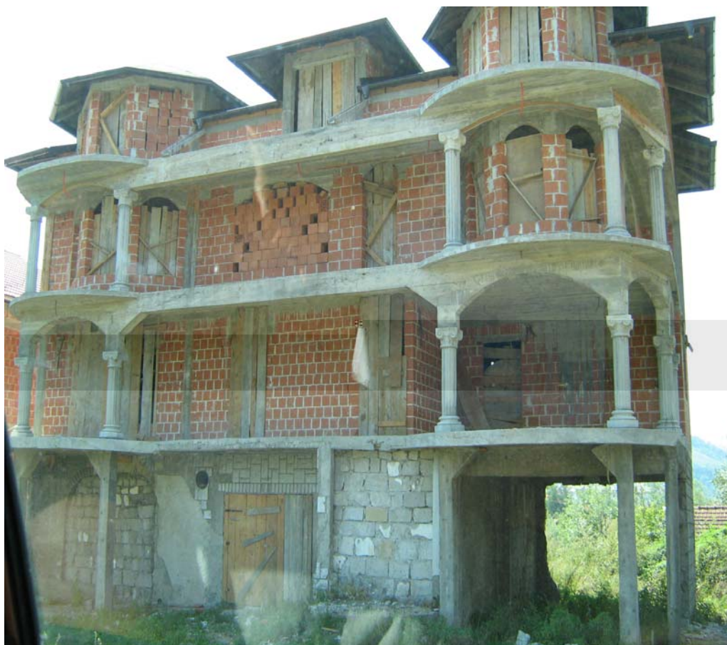
Novoizgrađena stambena jedinica
